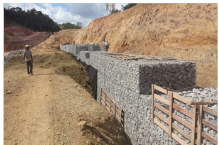
Durante la Obra
