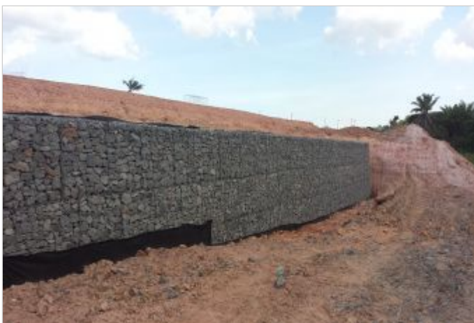
Durante la Obra
