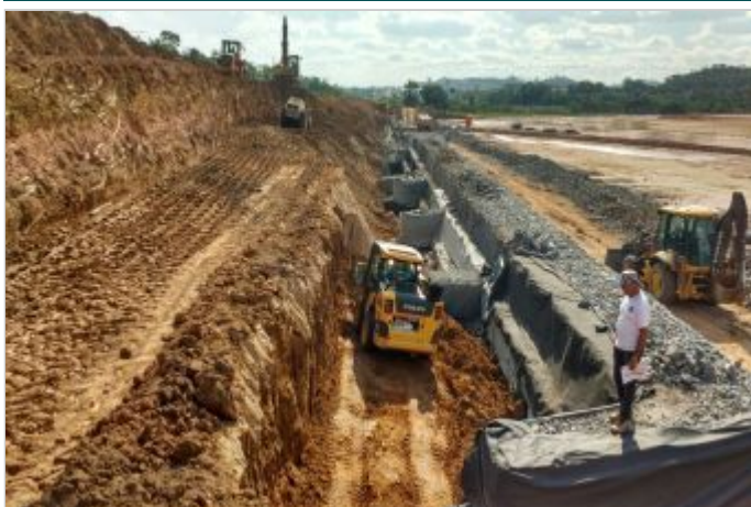
Durante la Obra
