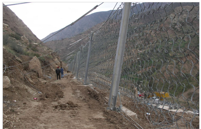
ΑΝΑΝΤΙ ΠΛΕΥΡΑ ΦΡΑΚΤΗ ΚΑΤΑ ΤΗ ΦΑΣΗ ΤΗΣ ΚΑΤΑΣΚΕΥΗΣ
