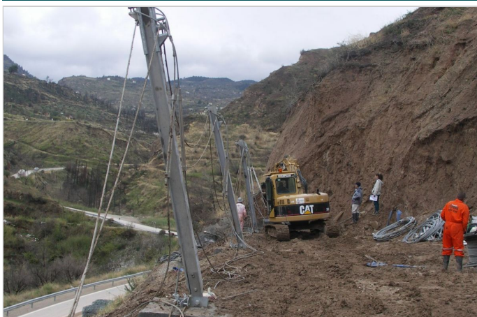
ΟΡΘΟΣΤΑΣΤΕΣ ΦΡΑΚΤΗ ΣΤΗ ΦΑΣΗ ΤΗΣ ΚΑΤΑΣΚΕΥΗΣ
