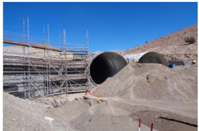
Durante la Obra
