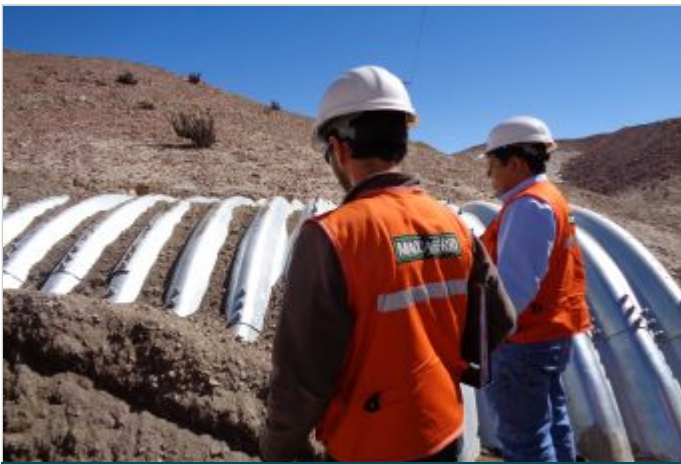
Durante la Obra
