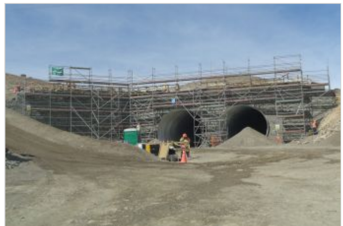
Durante la Obra
