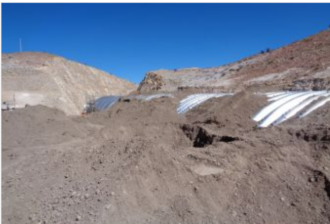
Durante la Obra
