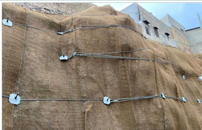
Fajas de cable para sujeción de bloques potencialmente inestables
