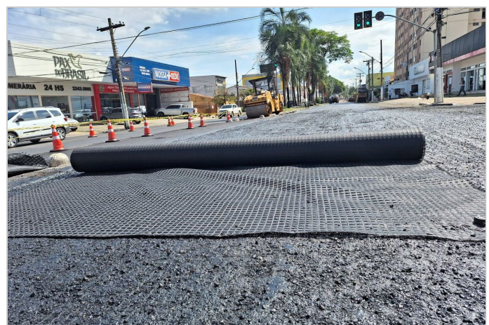
Durante a obra
