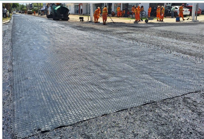
Durante a obra
