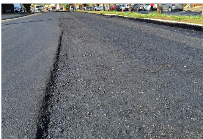
Durante a obra
