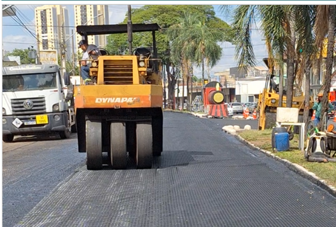
Durante a obra
