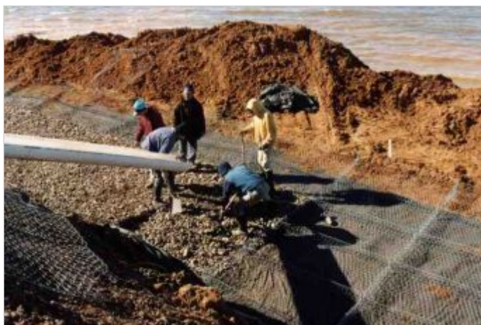
Durante a obra
