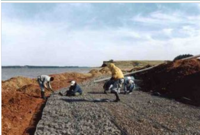
Durante a obra
