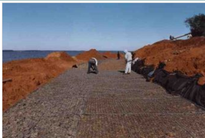
Durante a obra
