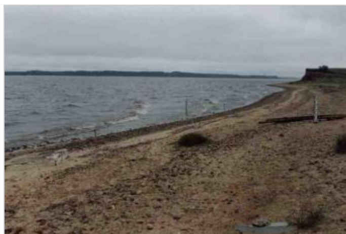
Durante a obra
