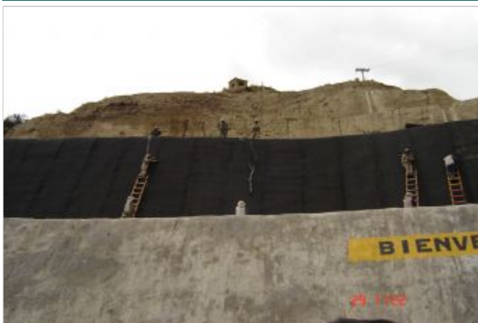
Durante la Obra
