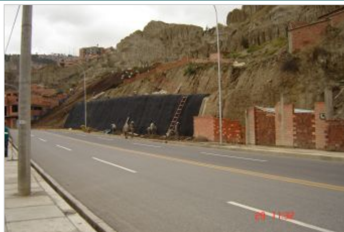
Durante la Obra
