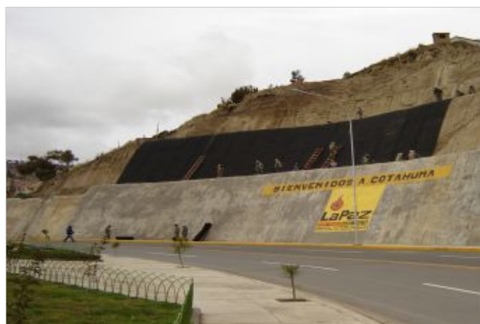
Durante la Obra
