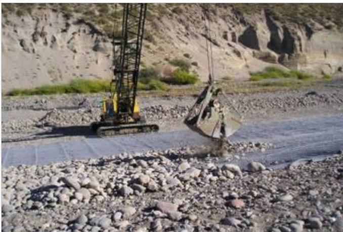
Durante la Obra
