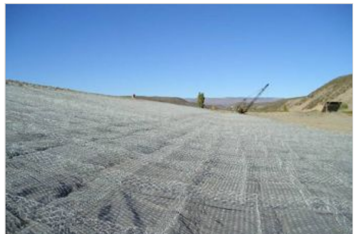
Durante la Obra
