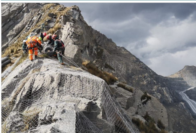
Durante la Obra
