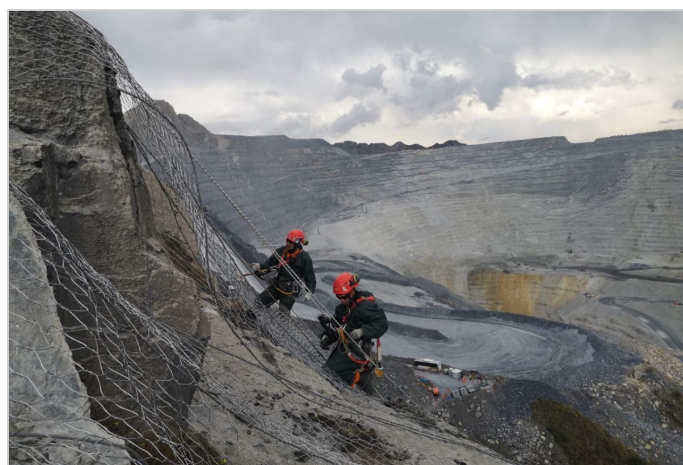
Durante la Obra
