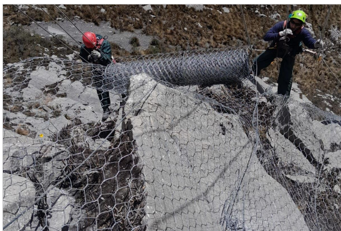
Durante la Obra
