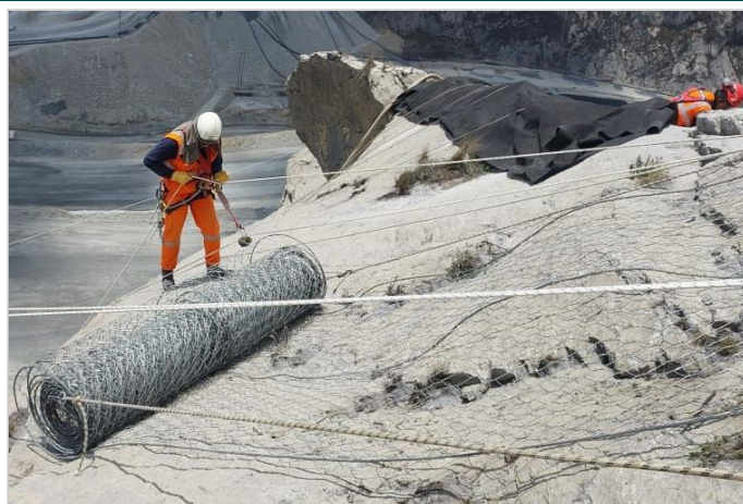
Durante la Obra
