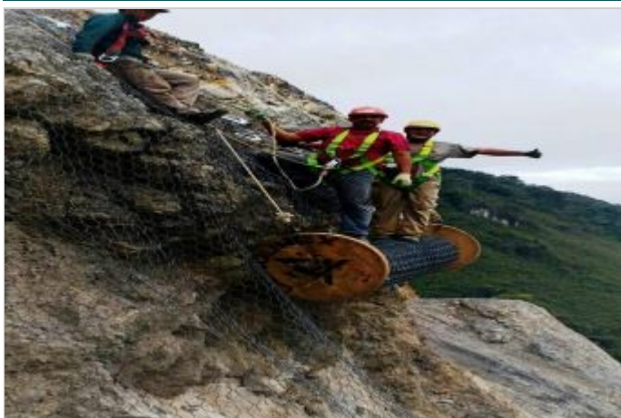
Durante la Obra
