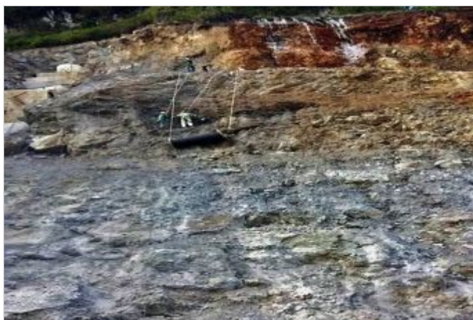
Durante la Obra
