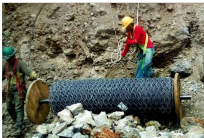
Durante la Obra
