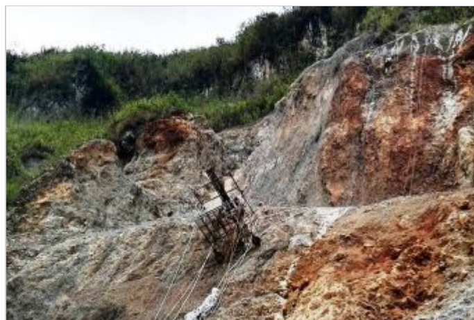
Durante la Obra
