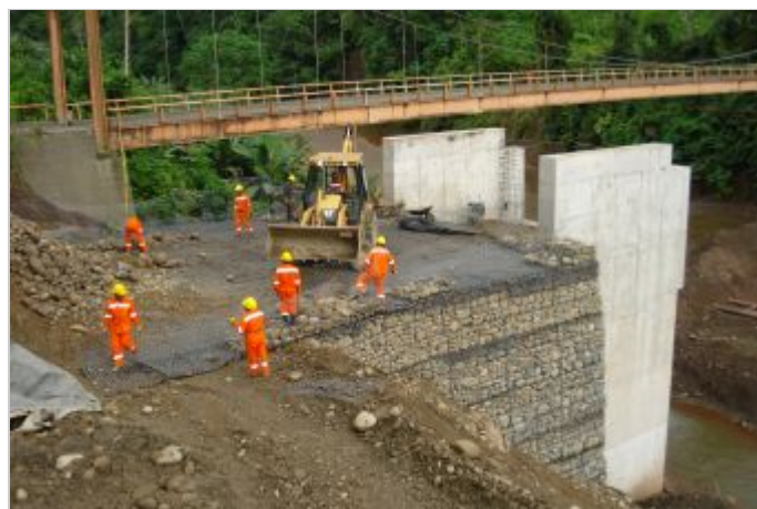
Durante la Obra
