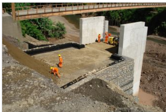
Durante la Obra
