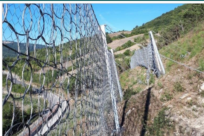
Vista di dettaglio delle barriera paramassi RB 2000 installate
