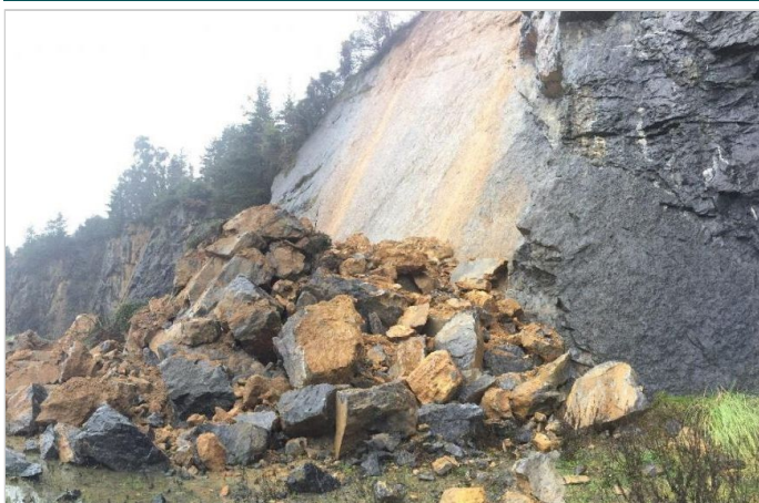
Vista del material desprendido en febrero de 2018
