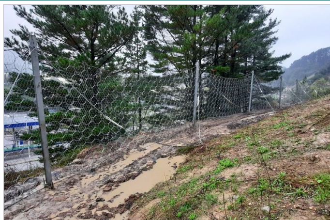
Instalación de la barrera dinámica RB 1500, H=4m, L=60m
