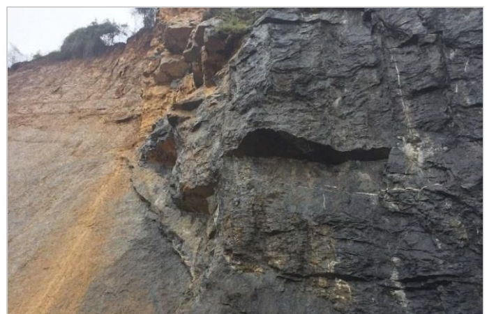
Detalle de la raíz de la cuña que ha quedado en situación comprometida
