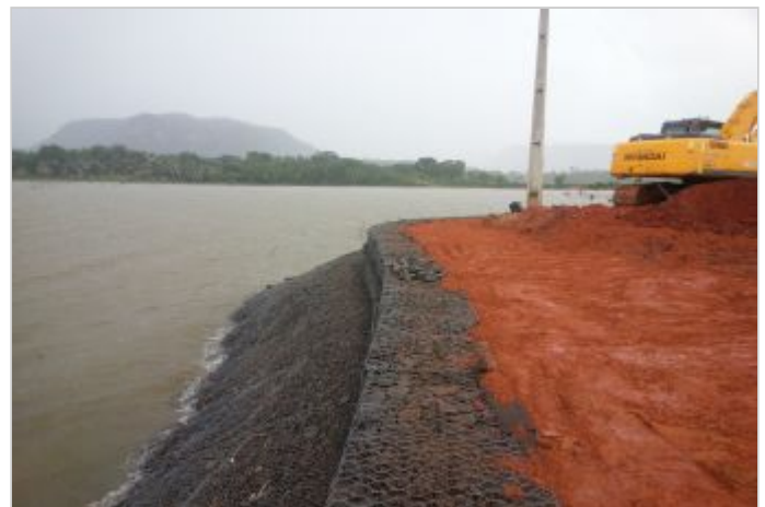
Durante a obra
