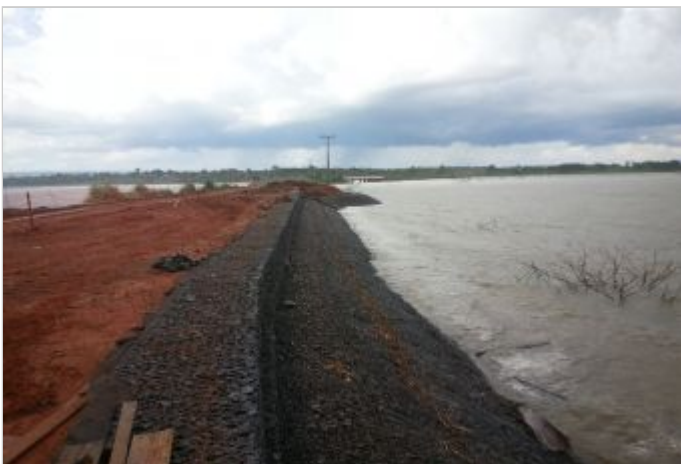
Durante a obra
