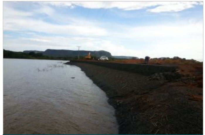
Durante a obra
