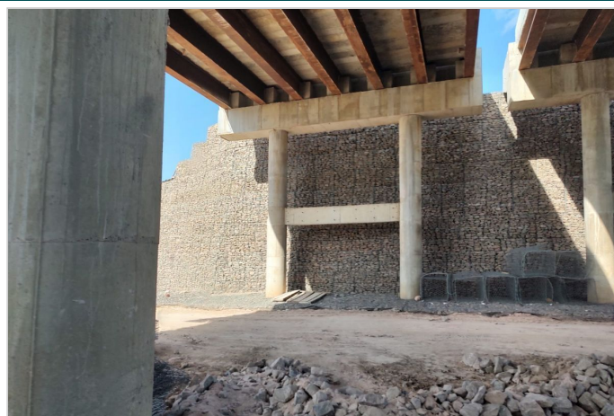
Durante a obra
