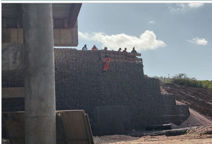
Durante a obra
