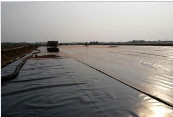
Durante la Obra
