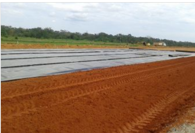
Durante la Obra
