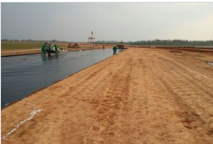
Durante la Obra
