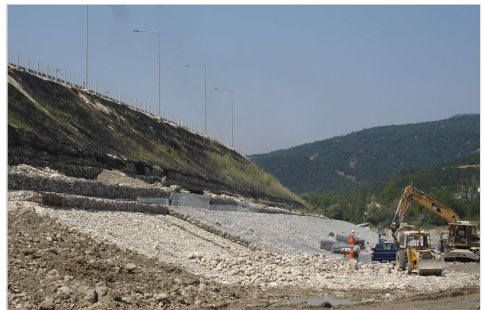
ΠΡΟΚΑΤΑΣΚΕΥΑΣΜΕΝΑ ΖΝ ΣΥΡΜΑΤΟΚΙΒΩΤΙΑ ΣΤΗ ΦΑΣΗ ΤΗΣ ΚΑΤΑΣΚΕΥΗΣ ΤΟΥΣ
