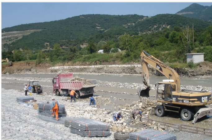
ΕΡΓΑΣΙΕΣ ΔΙΑΜΟΡΦΩΣΗΣ ΚΟΙΤΗΣ ΜΕ ΧΡΗΣΗ ΣΥΡΜΑΤΟΚΙΒΩΤΙΩΝ
