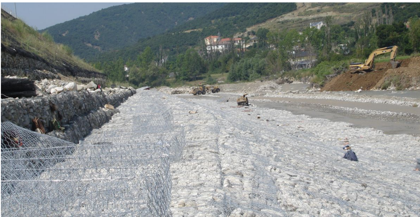
ΠΡΟΚΑΤΑΣΚΕΥΑΣΜΕΝΑ ΖΝ ΣΥΡΜΑΤΟΚΙΒΩΤΙΑ ΣΤΗΝ ΑΡΙΣΤΕΡΗ ΠΛΕΥΡΑ ΤΗΣ ΟΧΘΗΣ
