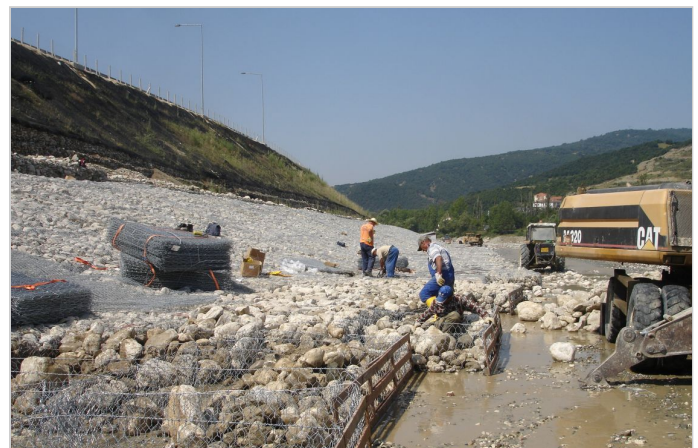
ΔΙΑΔΙΚΑΣΙΑ ΓΕΜΙΣΜΑΤΟΣ ΠΡΟΚΑΤΑΣΚΕΥΑΣΜΕΝΩΝ ΣΥΡΜΑΤΟΚΙΒΩΤΙΩΝ
