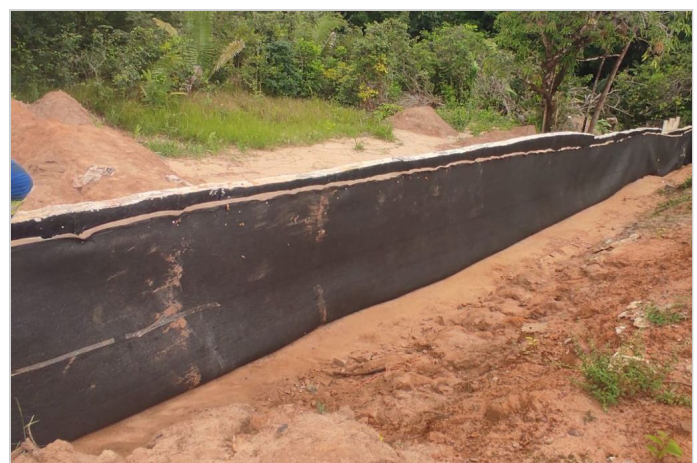
Durante a obra
