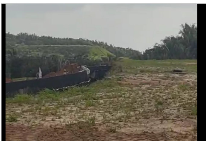
Durante a obra
