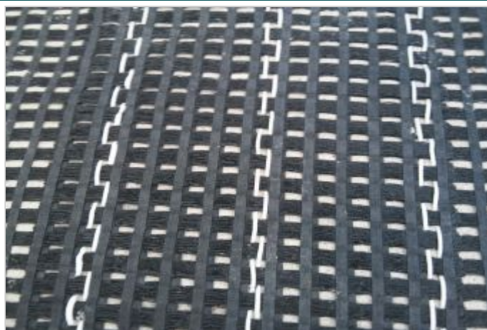
Durante la Obra
