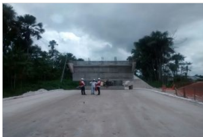
Durante la Obra
