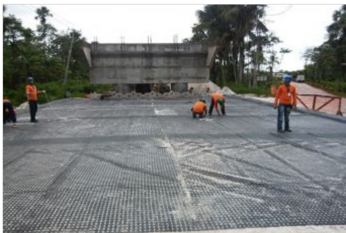
Durante la Obra
