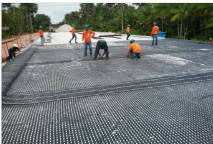
Durante la Obra
