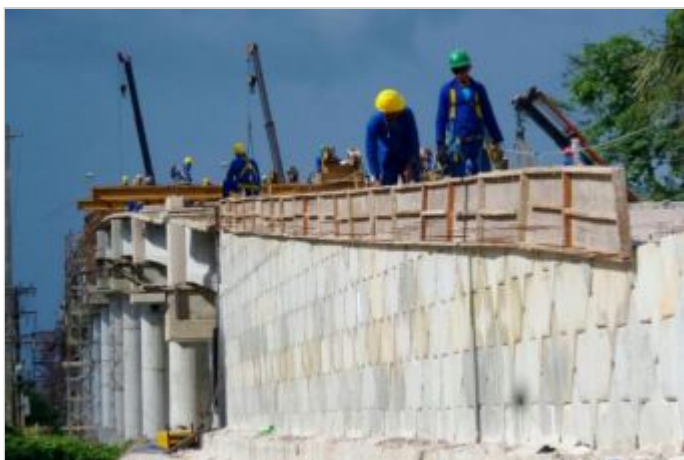
Durante la Obra
