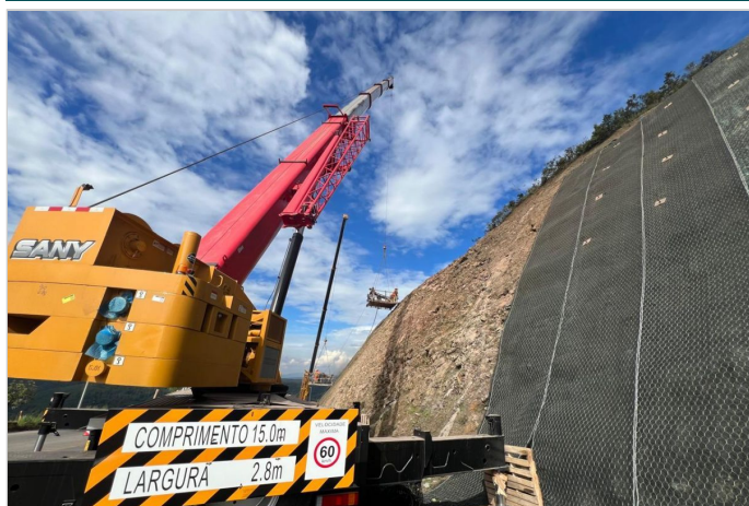
Durante a obra
