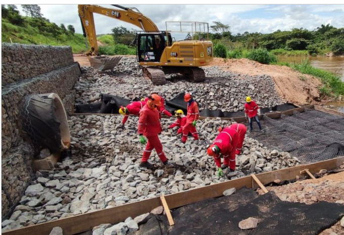
Durante a obra
