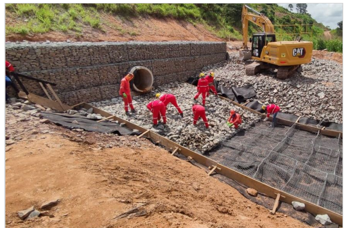
Durante a obra
