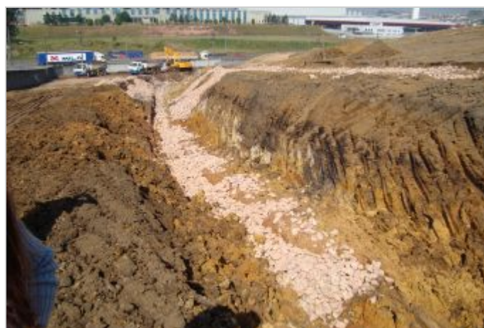
Durante la Obra
