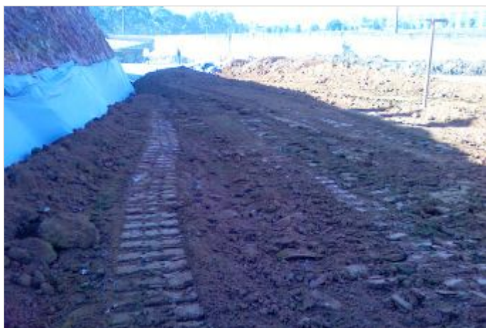
Durante la Obra
