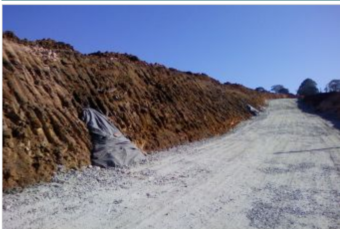
Durante la Obra
