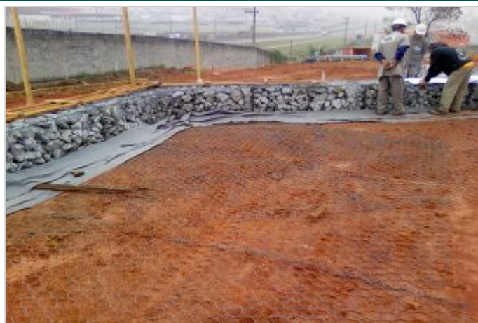
Durante la Obra
