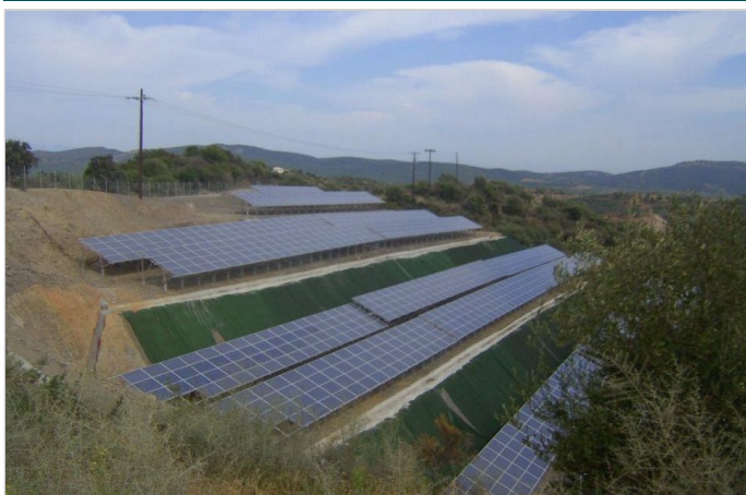
ΕΠΕΝΔΥΣΗ ΠΡΑΝΩΝ ΜΕ 3-D ΓΕΩΠΛΕΓΜΑ ΜΑCΜΑΤ 8.1 GREEN
