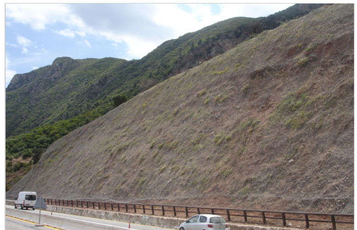
Τοποθετημένο το σύστημα Steelgrid Mo
