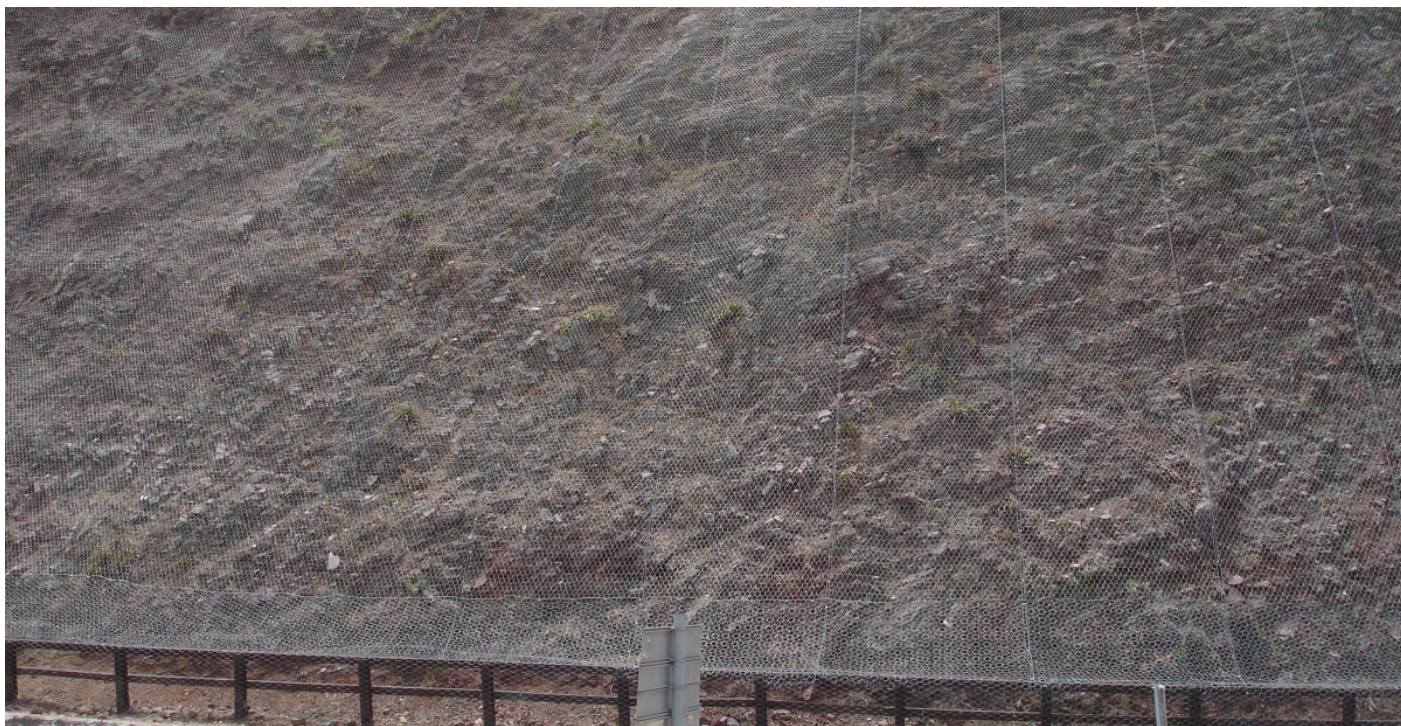
Τμήμα πρανούς με τοποθετημένο Steelgrid Mo
