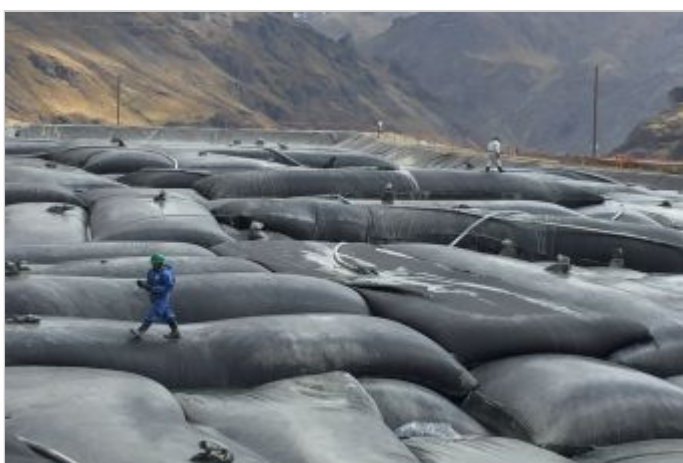
Durante la Obra
