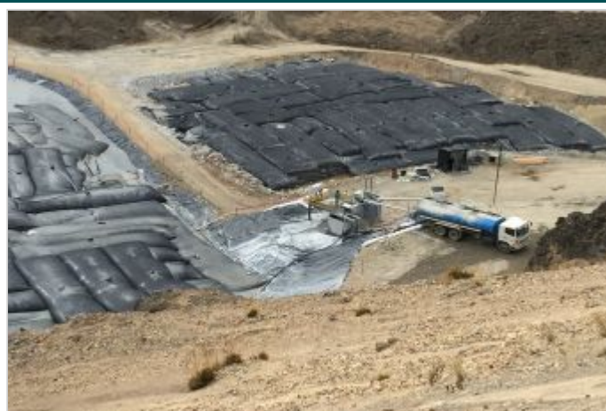
Durante la Obra
