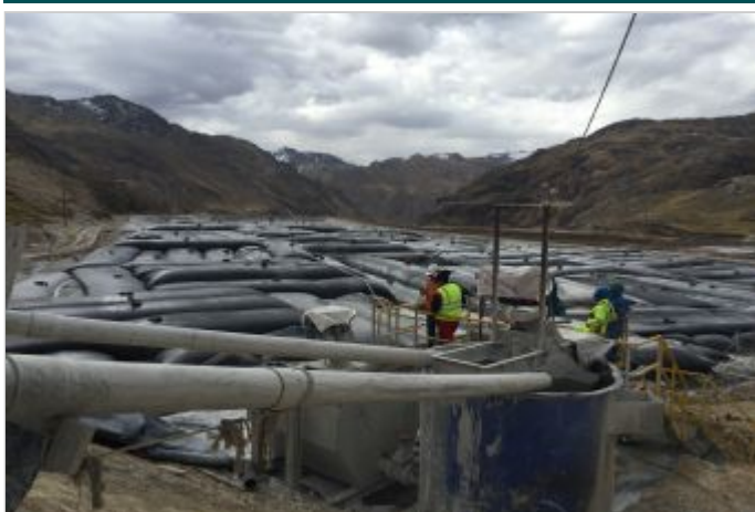
Durante la Obra
