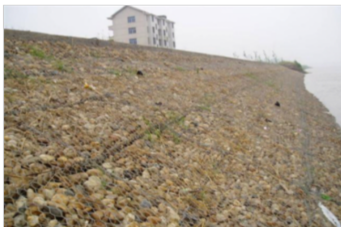
刚施工完两周，开始有小草生长
