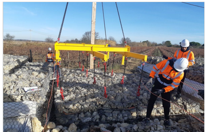
Préparation des RenoMac sur le haut de la berge
