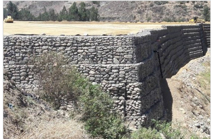
Durante la Obra
