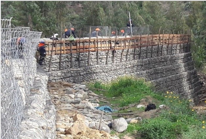
Durante la Obra
