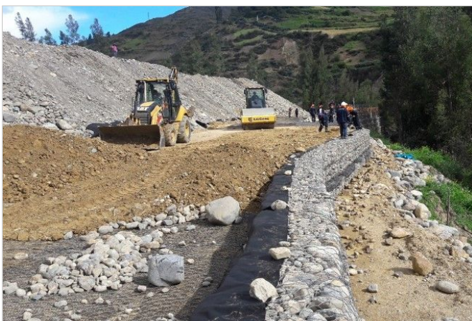
Durante la Obra
