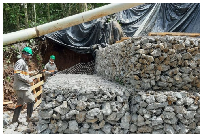
Durante a obra
