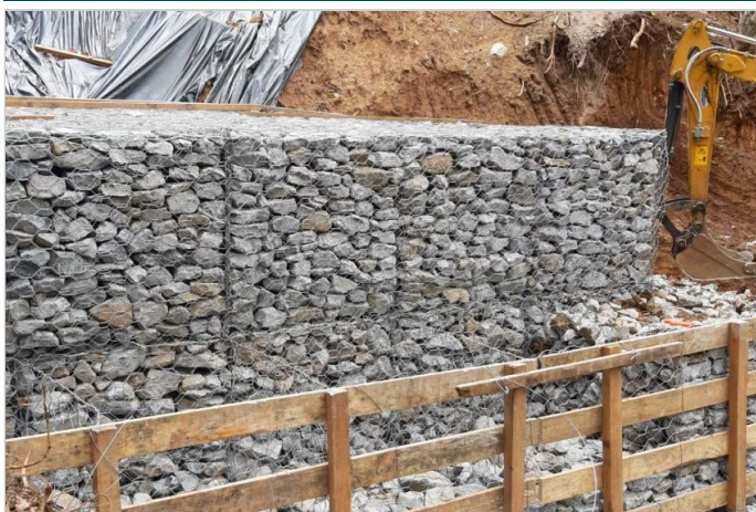
Durante a obra
