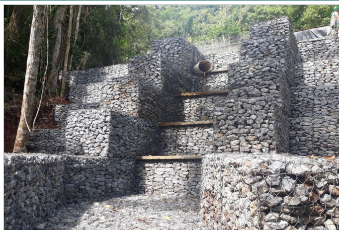
Durante a obra
