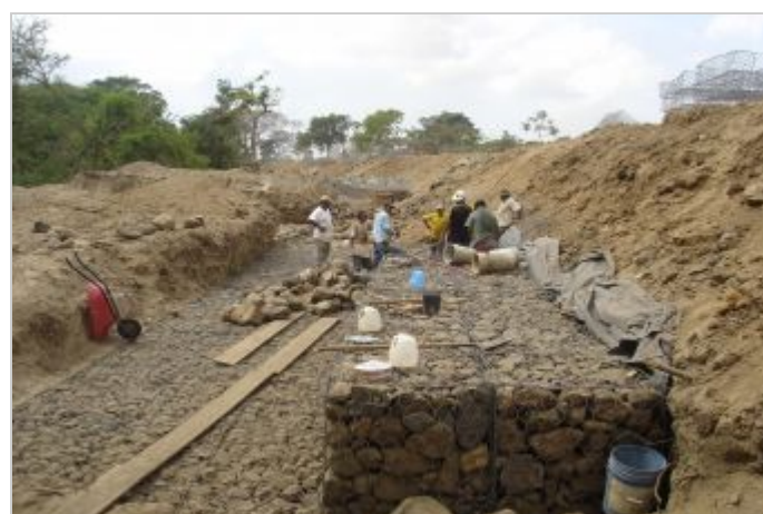
Durante a obra
