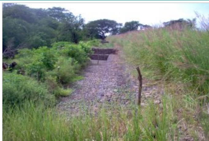
Durante a obra
