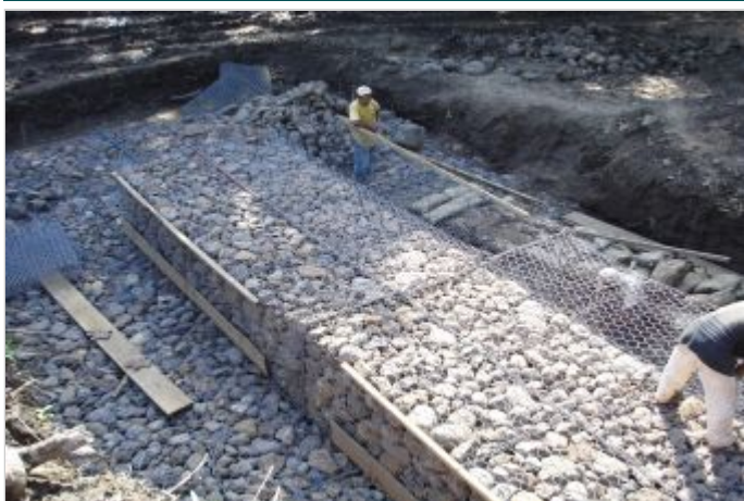
Durante a obra
