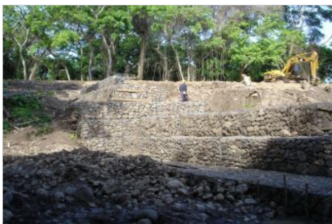
Durante a obra
