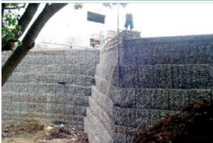
Durante la Obra
