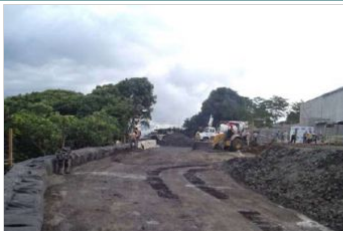
Durante la Obra
