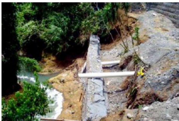
Durante la Obra
