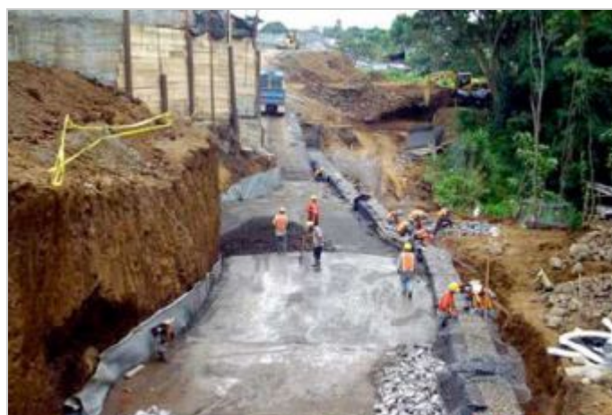
Durante la Obra
