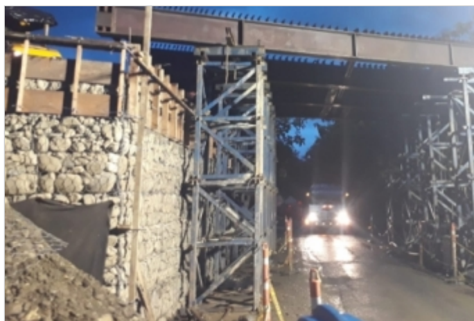
Durante la Obra
