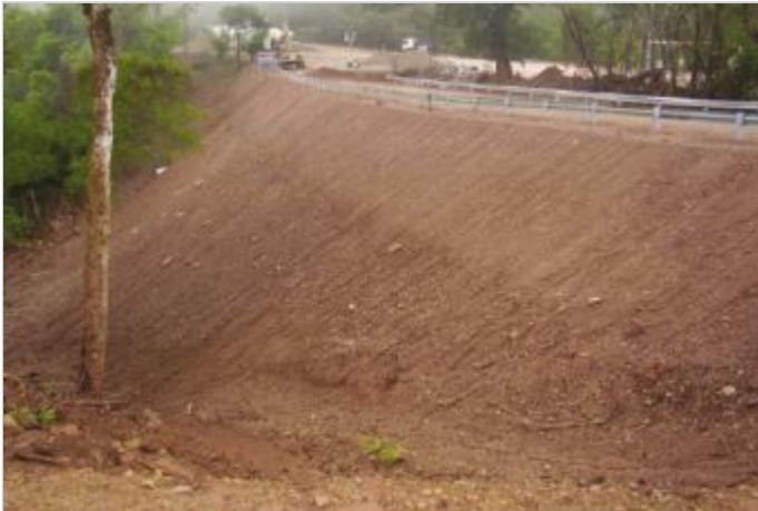
Durante la Obra
