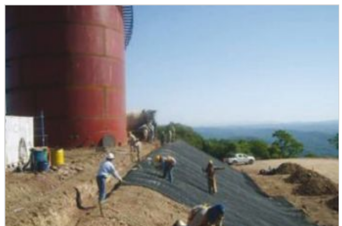
Durante la Obra
