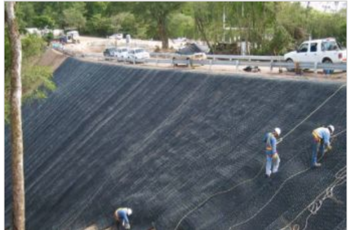
Durante la Obra
