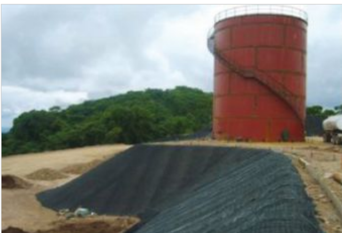
Durante la Obra
