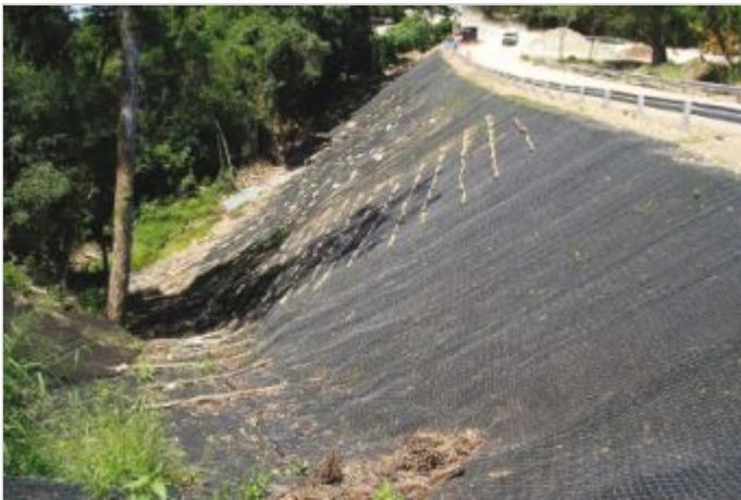
Durante la Obra
