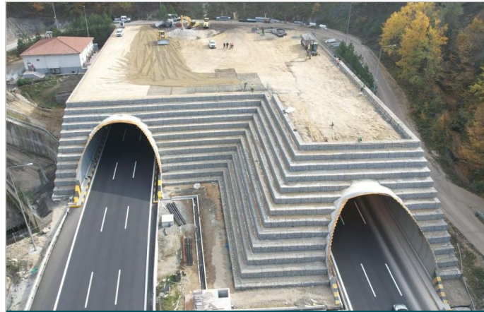
Terramesh Sistem ile Kaplı Tünelin Bitmiş Hali
