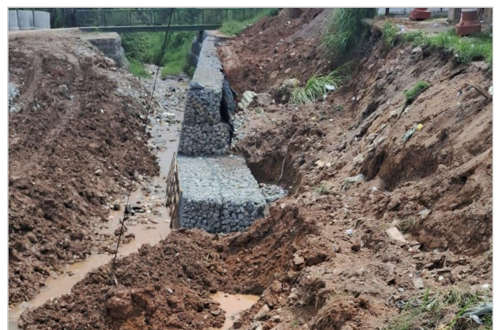
Durante a obra
