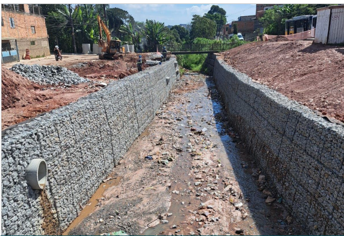
Durante a obra
