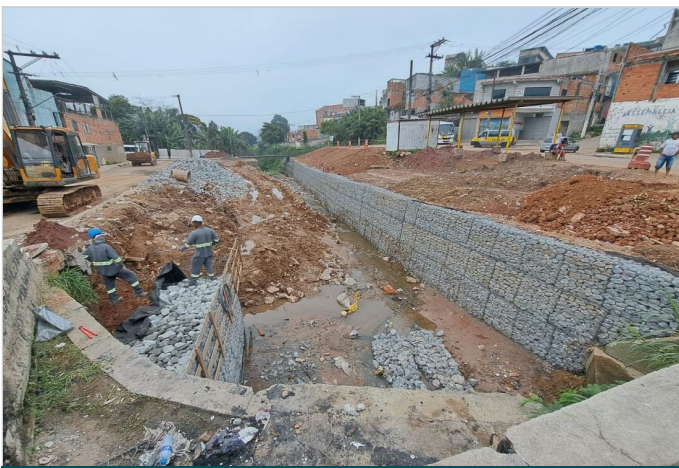
Durante a obra
