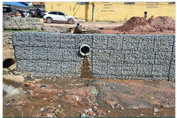
Durante a obra
