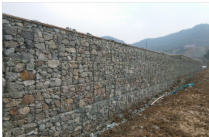
图二：项目施工中
