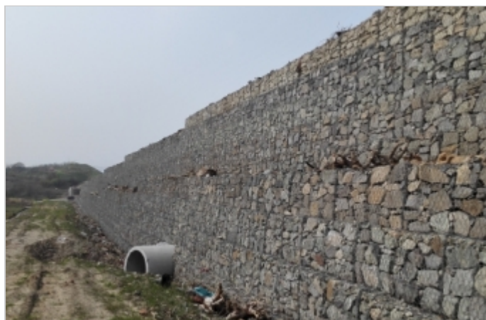
图一：项目施工中
