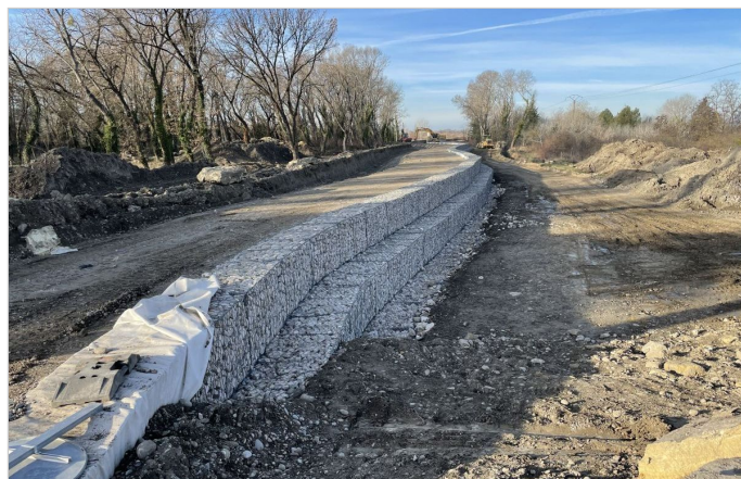
Matelas Reno Plus recouverts de terre végétale
