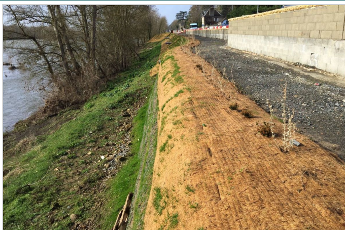
Après la mise en oeuvre, février 2020
