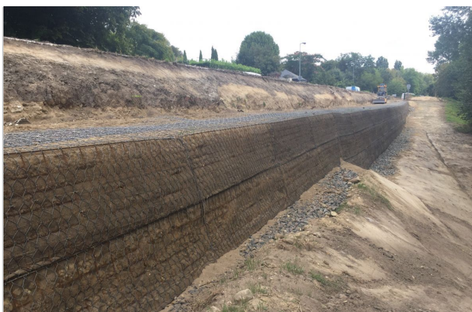
Pendant la mise en œuvre, août 2019
