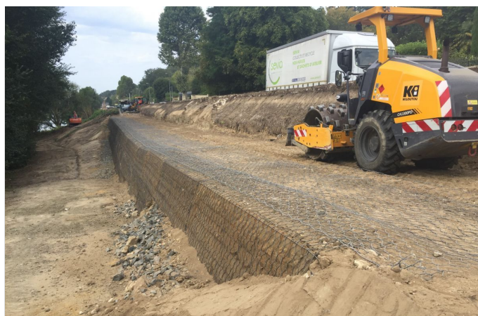
Pendant la mise en œuvre, août 2019
