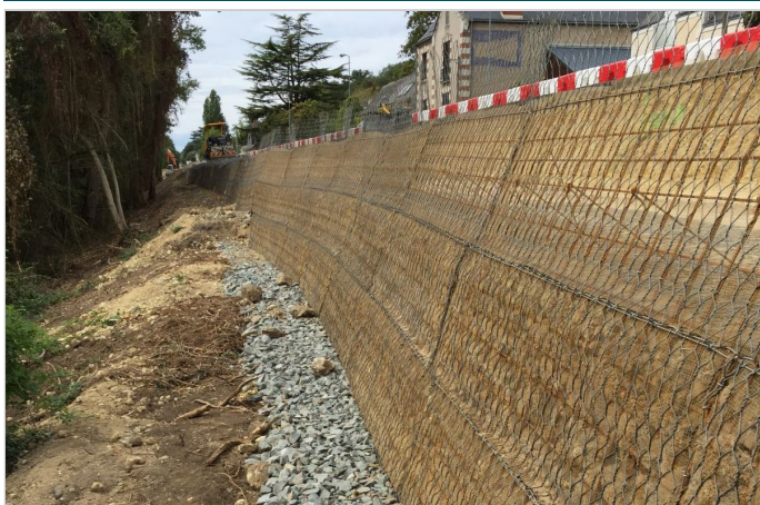
Pendant la mise en oeuvre, août 2019
