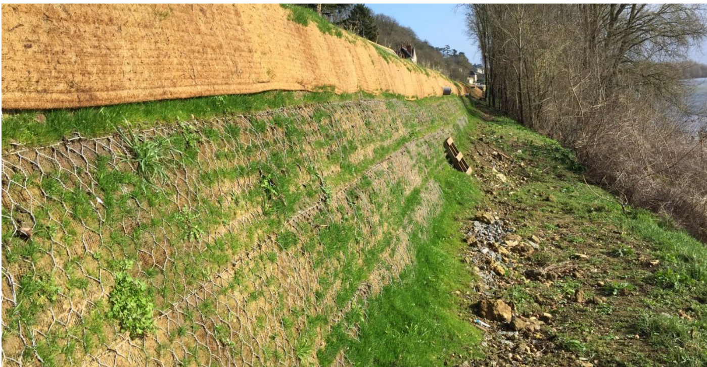
Après la mise en oeuvre, février 2020
