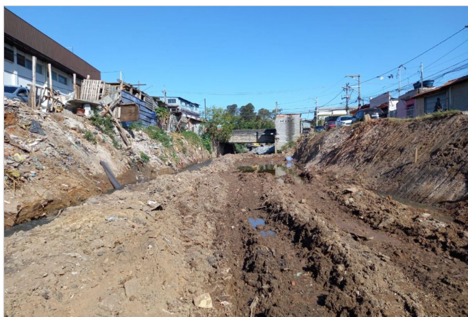
Durante a obra
