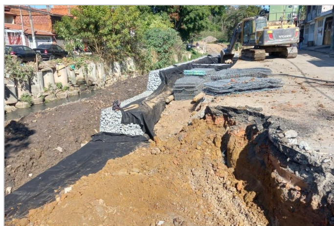
Durante a obra
