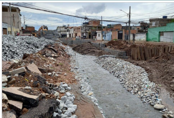
Durante a obra
