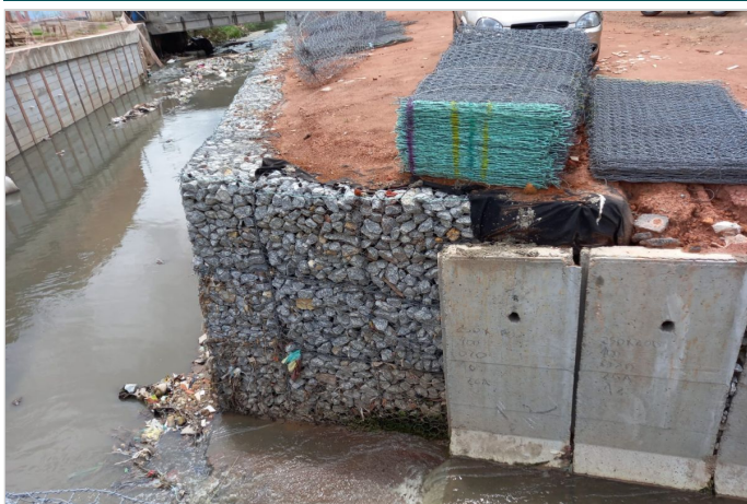
Durante a obra
