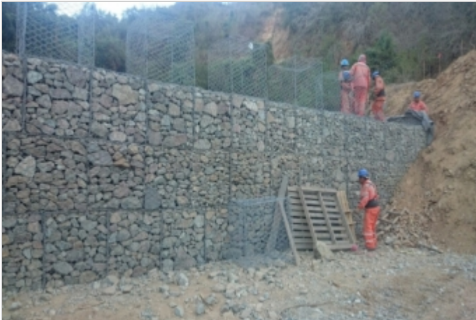
Durante la Obra
