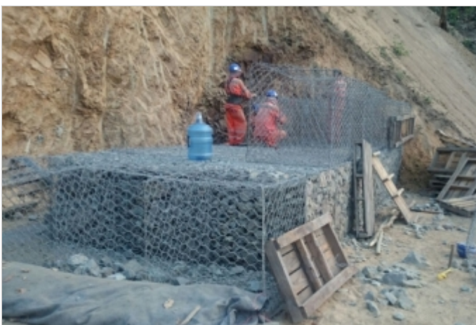
Durante la Obra
