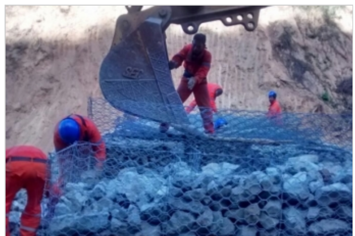
Durante la Obra
