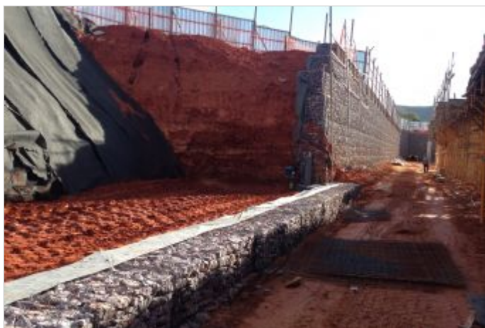
Durante la Obra
