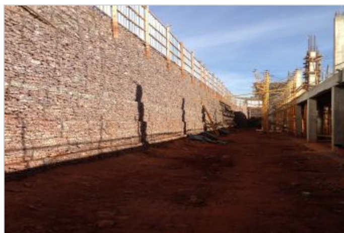
Durante la Obra
