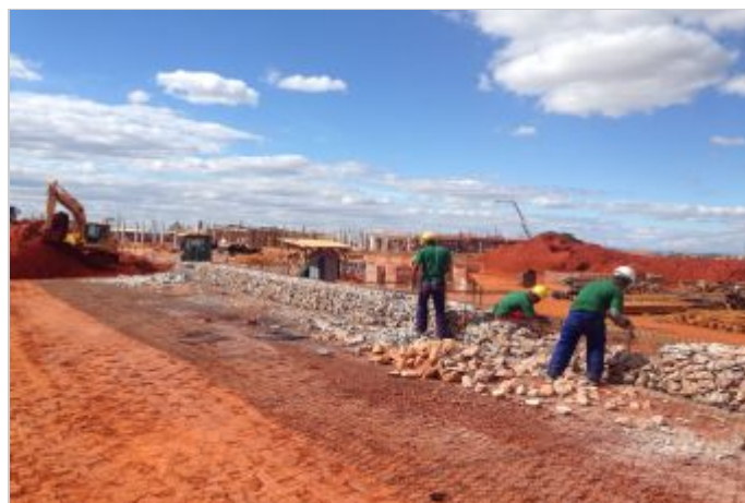
Durante la Obra
