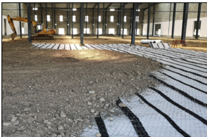
软基垫碎石摊铺现场
