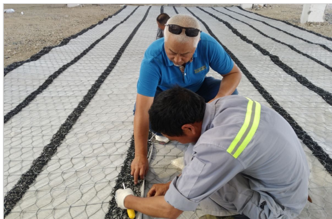
现场链接施工
