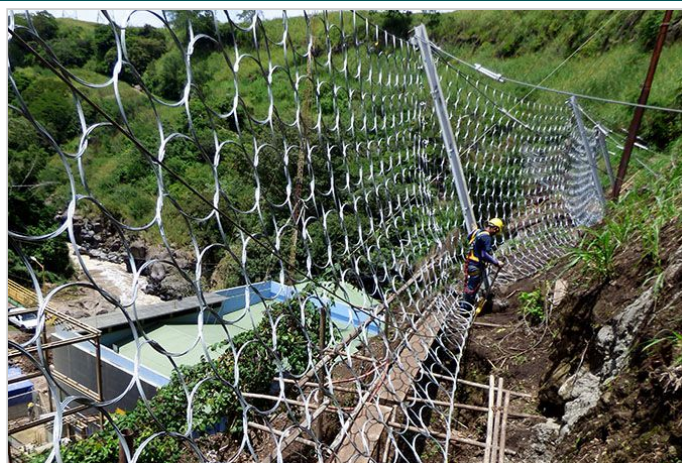
Durante la Obra
