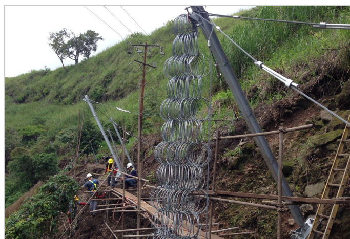
Durante la Obra
