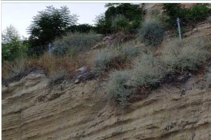
ΚΑΤΑ ΤΗ ΔΙΑΡΚΕΙΑ ΤΗΣ ΤΟΠΟΘΕΤΗΣΗΣ
