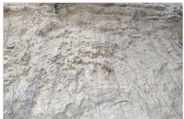
ΚΑΤΑ ΤΗ ΔΙΑΡΚΕΙΑ ΤΗΣ ΤΟΠΟΘΕΤΗΣΗΣ
