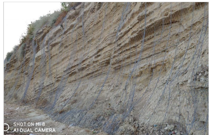
ΚΑΤΑ ΤΗ ΔΙΑΡΚΕΙΑ ΤΗΣ ΤΟΠΟΘΕΤΗΣΗΣ
