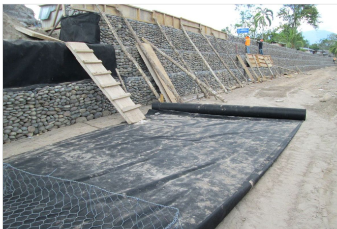
Durante la Obra
