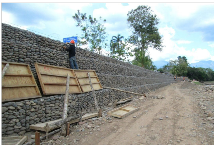
Durante la Obra
