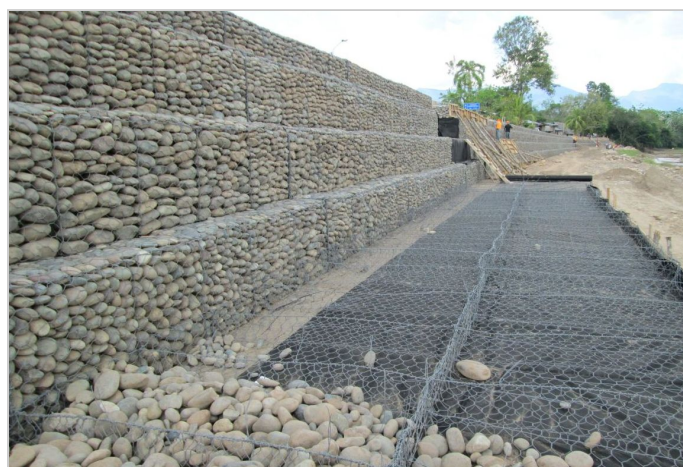
Durante la Obra
