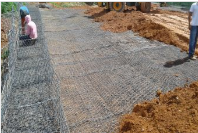
Durante la Obra
