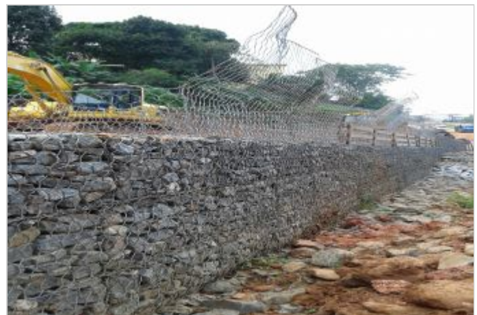
Durante la Obra
