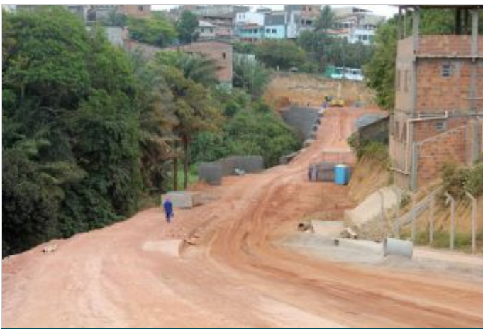
Durante la Obra
