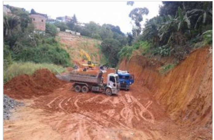
Durante la Obra
