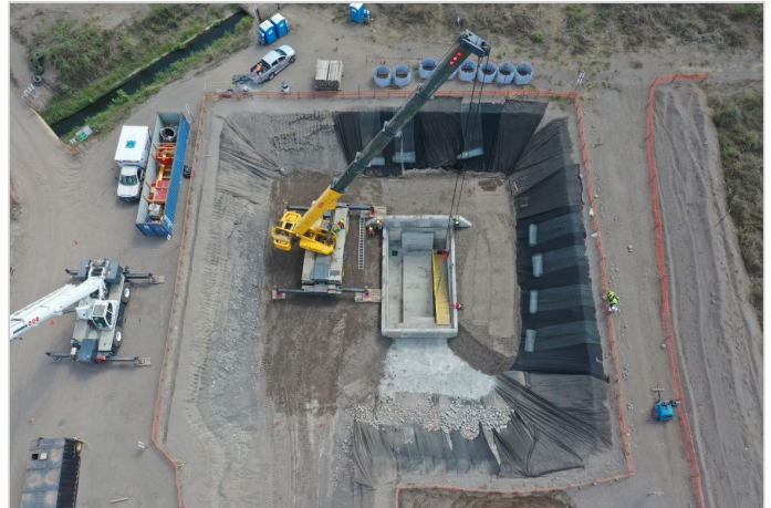
Durante la Obra
