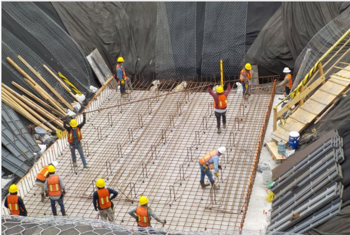
Durante la Obra
