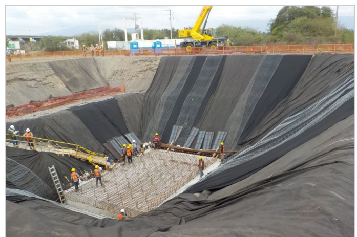
Durante la Obra
