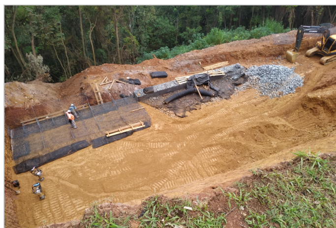
Durante a obra
