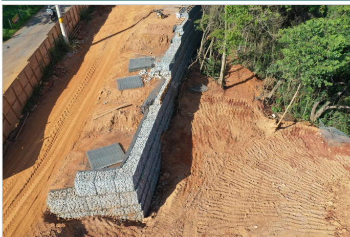
Durante a obra
