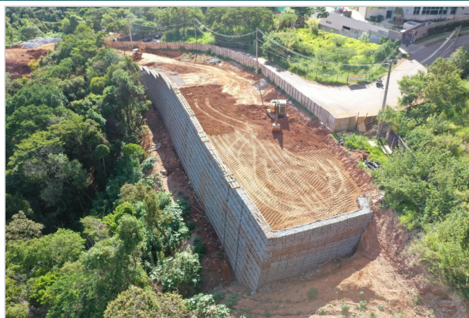
Durante a obra
