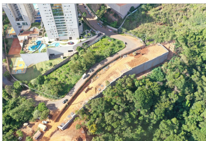
Durante a obra
