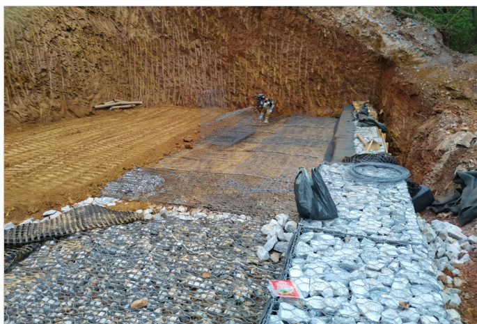
Durante a obra
