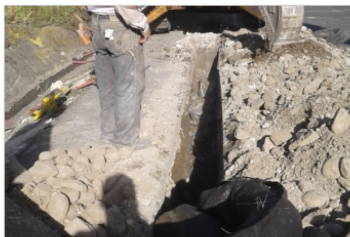
Durante a obra
