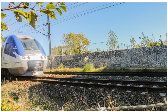
Mur en gabions
