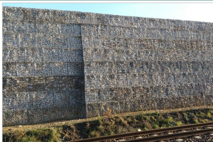
Mur en Terramesh System
